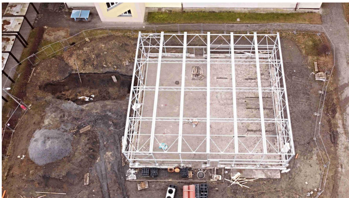
Obr. 1. Výstavba konstrukce skleníku
