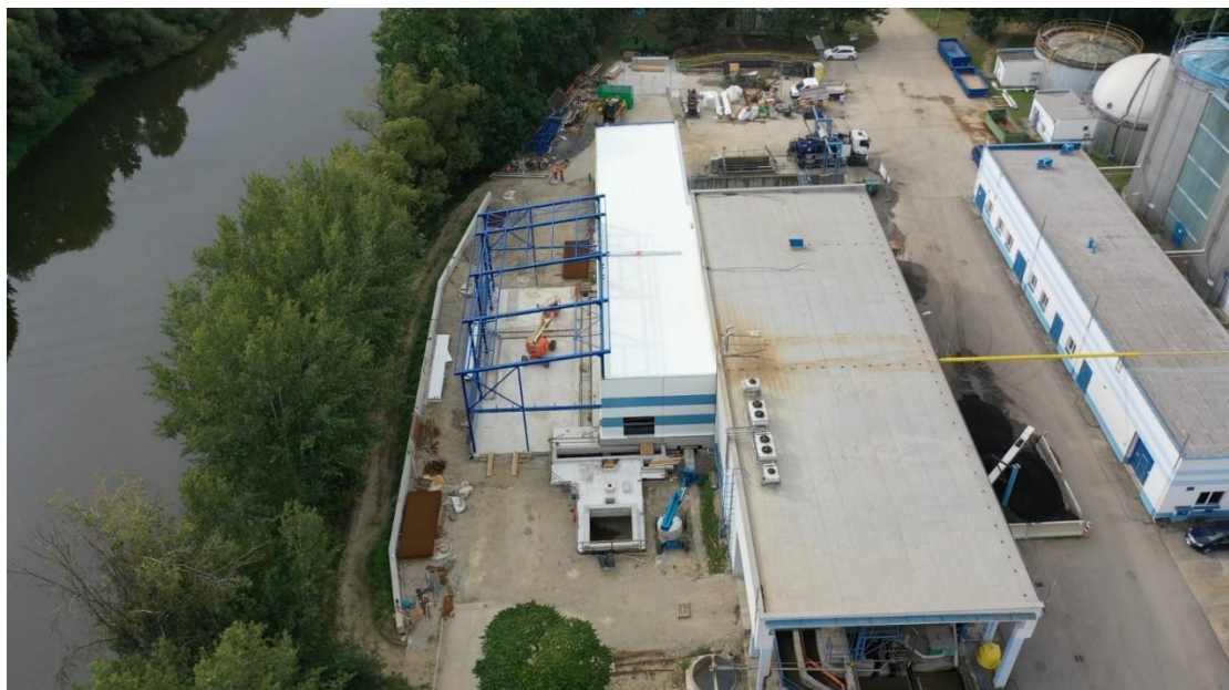
Obr. 2. Kalový bunkr; hala sušárny a přístřešek pro pyrolyzér
