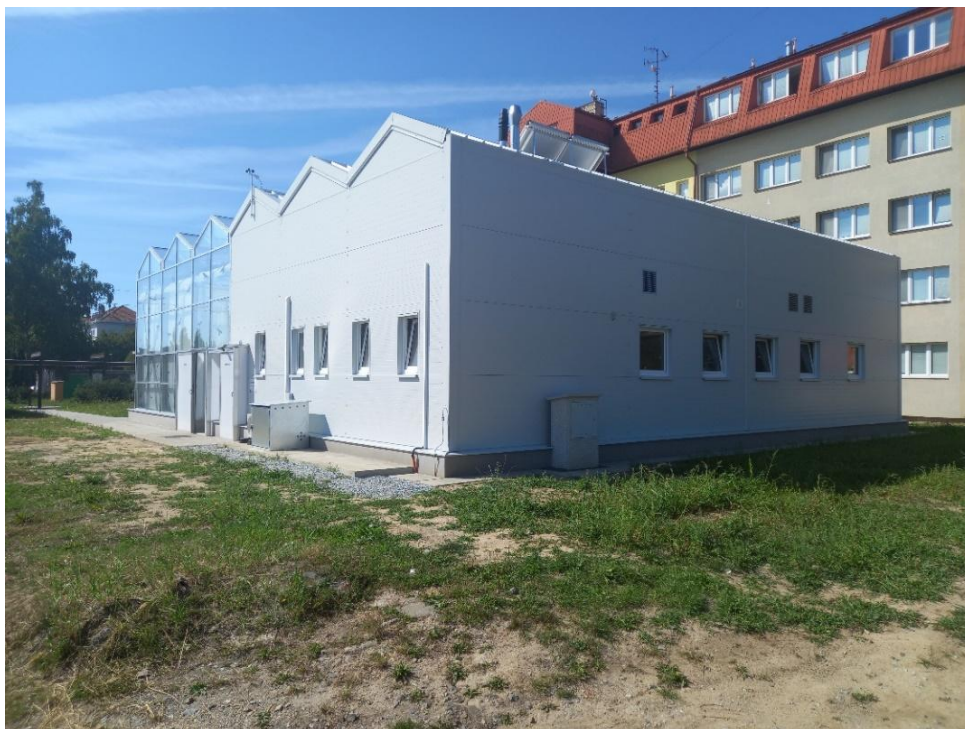
Obr. 3. Pohled na hydroponickou část budovy
