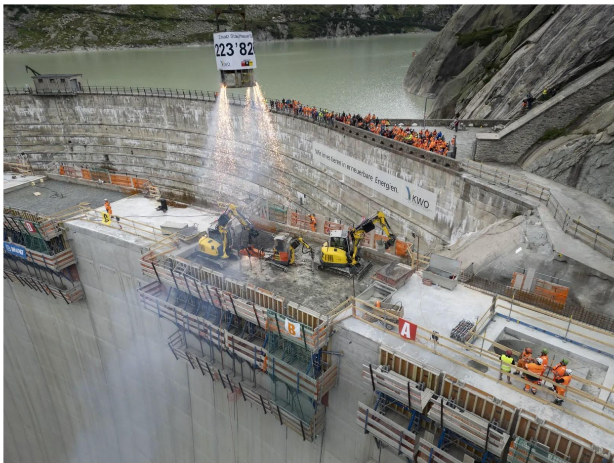
Obr. 13. Poslední badie, celkem uloženo 223 826 m 3 betonové směsi
