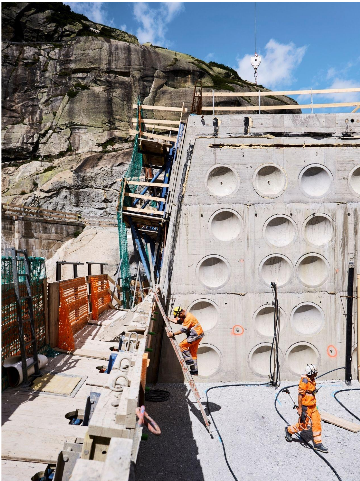
Obr. 12. Svislá a vodorovná pracovní spára
