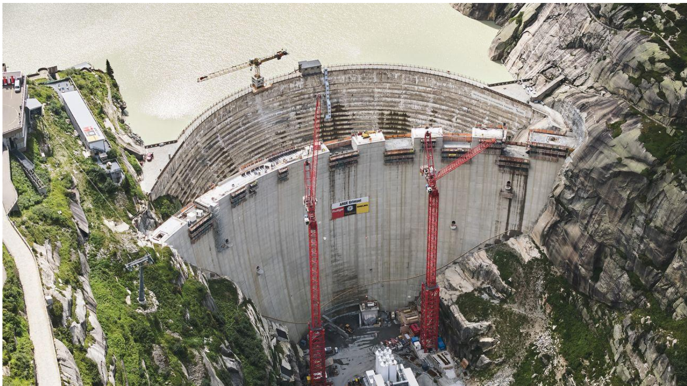
Obr. 18. Staveniště v závěrečné fázi betonáže hráze
