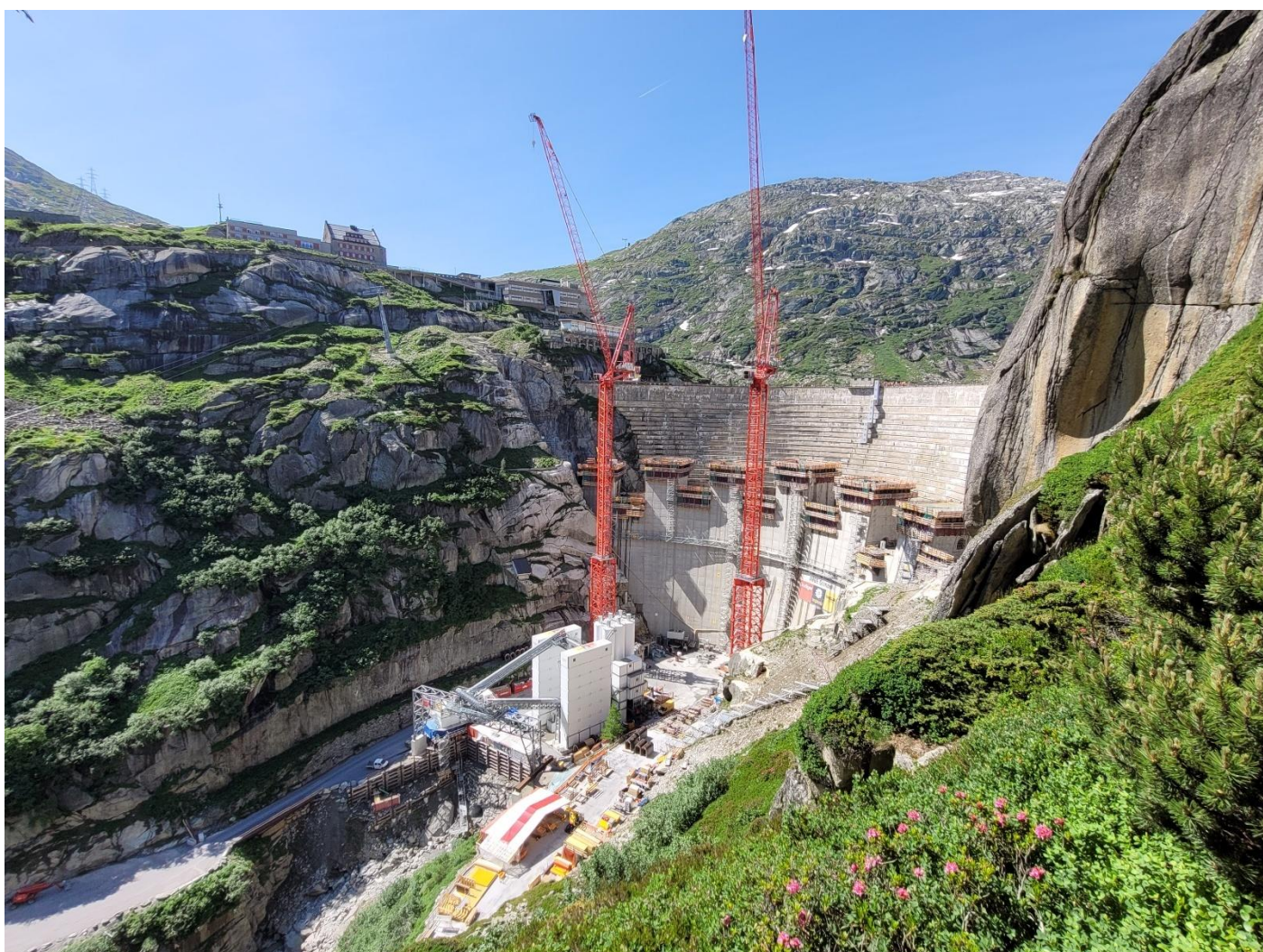
Obr. 17. Celkový pohled na staveniště v červnu 2023
