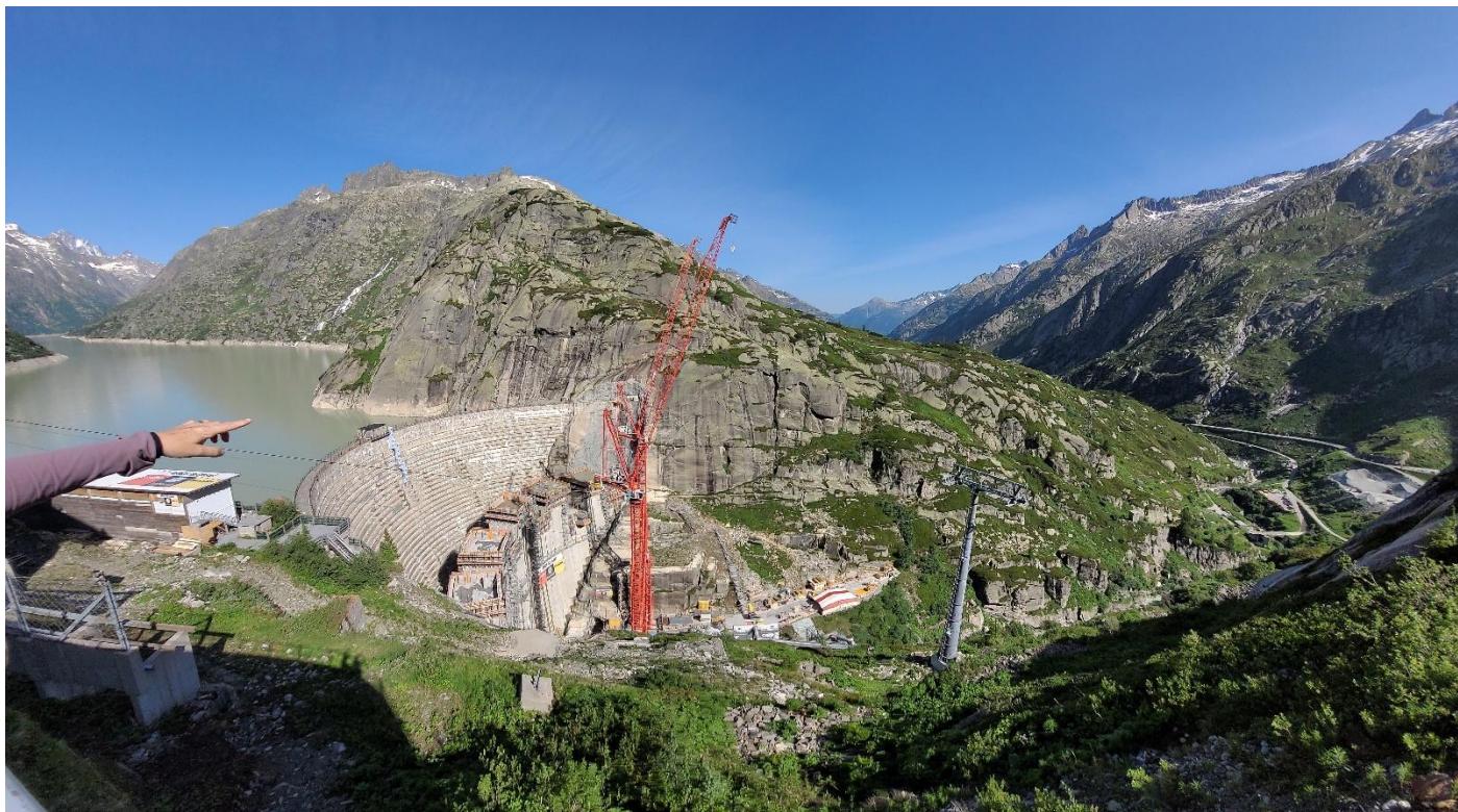
Obr. 16. Celkový pohled na staveniště v červnu 2023
