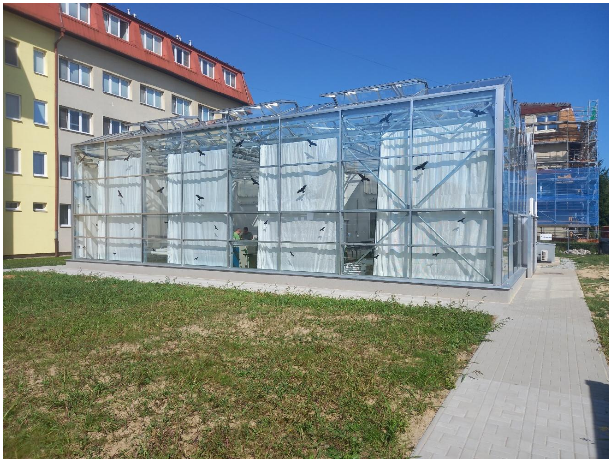
Obr. 2. Pohled na aquaponickou část budovy
