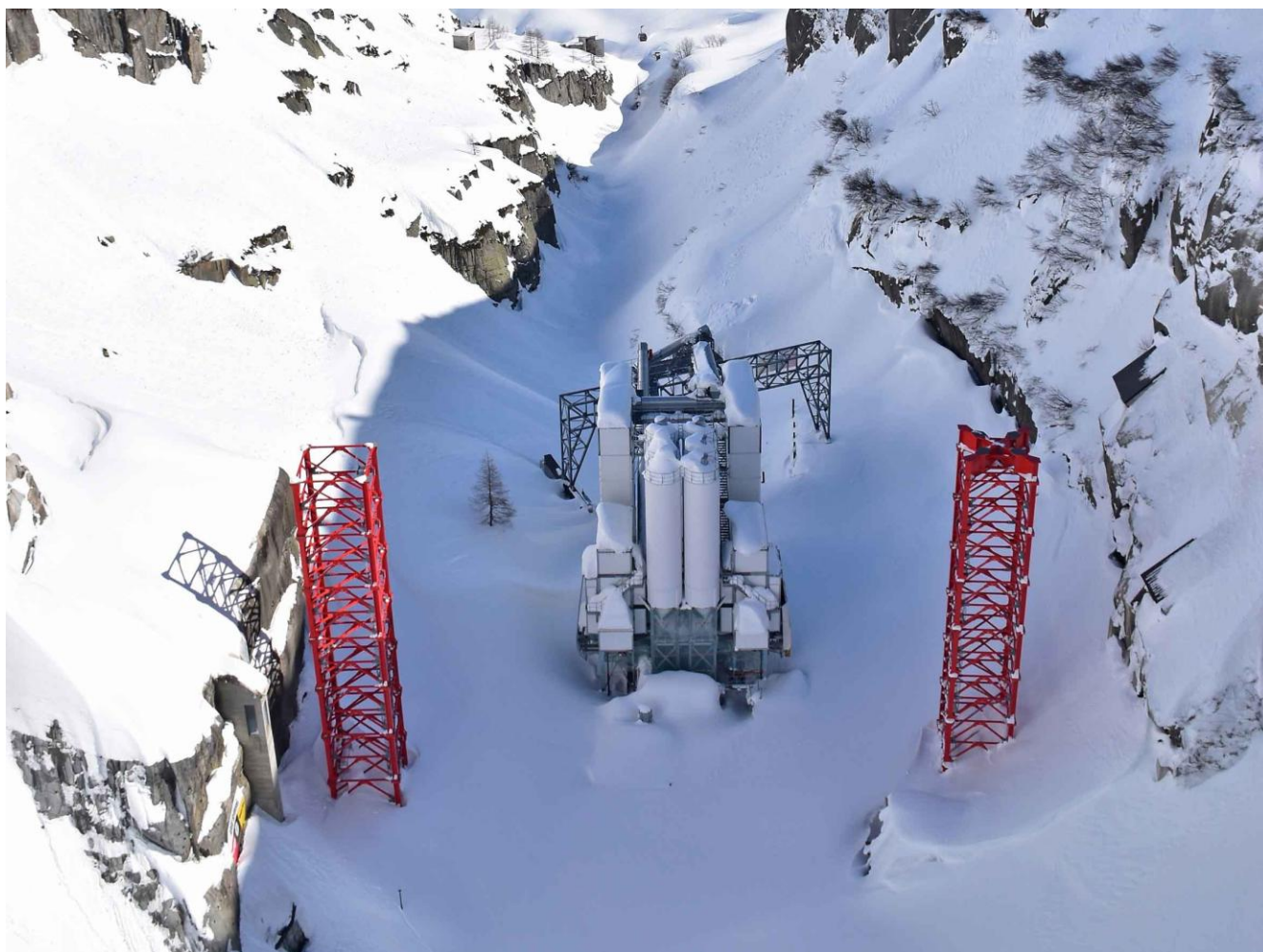
Obr. 8. Staveniště během zimní přestávky 2019/2020
