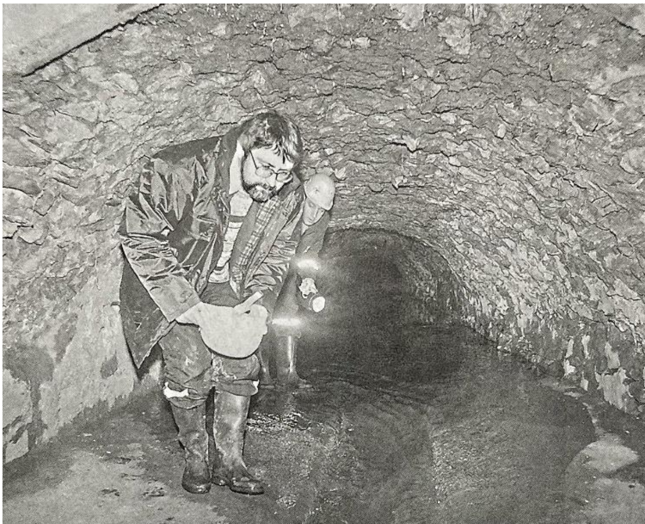
16) Klenutá kanalizační stoka pod parkem Na Sadech, provozní revize, 03/2005
