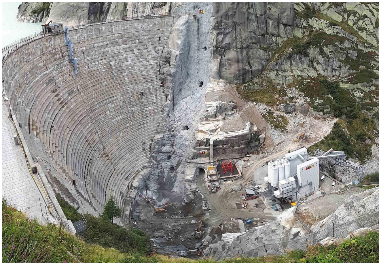
Obr. 6. Zakládání nové hráze, montáž betonáren a jeřábů
