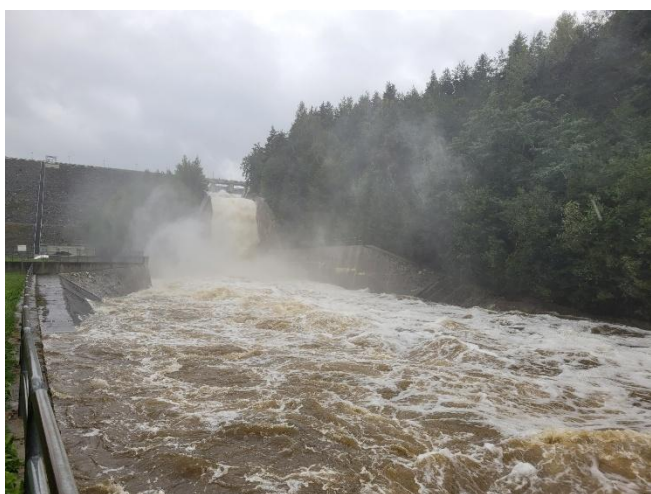
Obr. 2: Přepadající voda přes přeliv vodního díla Římov 15. 9. 2024 při odtoku 150 \text{ m}^3/\text{s} . Zdroj: Archiv autora
