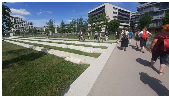
Obr. 31. Snížení úrovně pobytového trávniku umožňuje vsak přívalových srážek v centru vídeňské čtvrti Aspern, 2024
