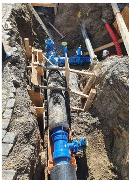
Obr. 6. Postup výstavby shybky – montáž shybky
