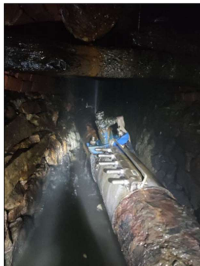
Obr. 2. Opravný třmen na stávajícím vodovodu OC 200
