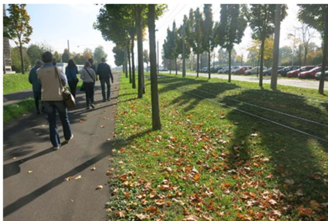
Obr. 28. Zastínění tramvajové trati proti výparu v linecké čtvrti SolarCity, 2017
