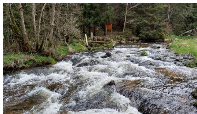
Obr. 4. Foto původního místa jezu Mairspindt po provedeném zásahu
