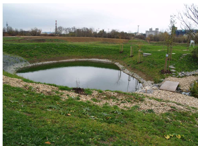
Obr. 16. Ukázka nádrže s infiltračními plochami, LIKO-S ve Slavkově u Brna
