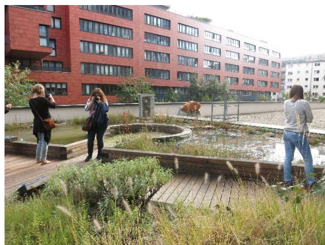
Obr. 18. Pochozí extenzivní zelená střecha na budově Magistrátu města Vídně, 2017
