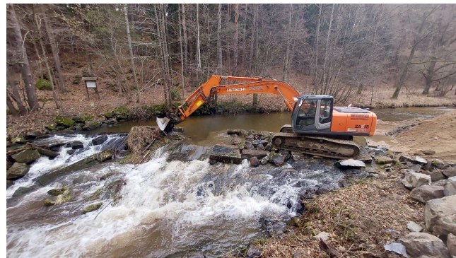
Obr. 5. Foto během zásahu – odbourání původní jezové hrany jezu Starý jez Geierhammer
