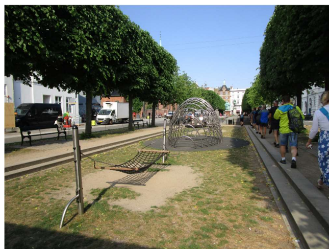
Obr. 32. Snížení úrovně pobytového trávniku umožňuje vsak přívalových srážek na náměstí Sankt Annæ Plads v Kodani (pod povrchem jsou akumulací nádrže na závlahu), 2018
