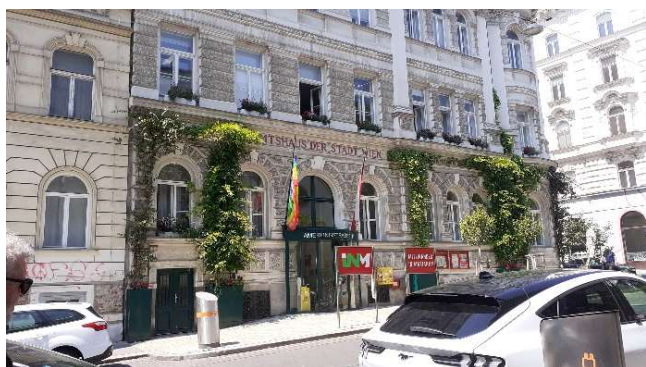
Obr. 9. Pohled na budovu magistrátu se zelenou fasádou ve Vídni, 2024
