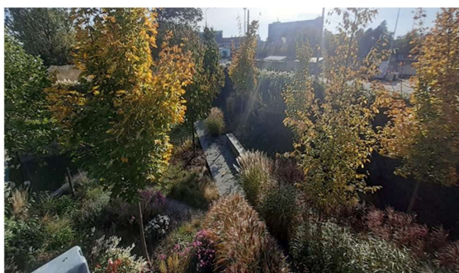
Obr. 6. Dešťová zahrada LIKO-S ve Slavkově u Brna, v centrální části je lávka a pod ní nátok srážkové vody ze střech objektu
