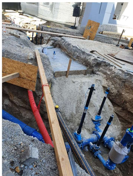
Obr. 9. Postup výstavby shybky – betonáž roznášecí desky nad izolovaným potrubím
