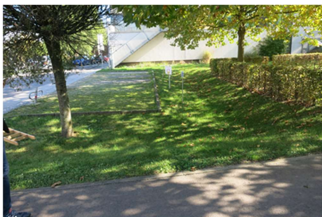
Obr. 29. Svedení srážkové vody z rezidenčních parkovišť do průlehů a zastínění trávníků vzrostlou zelení v linecké čtvrti SolarCity, 2017
