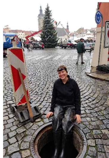
Obr. 3. Vánočně laděný průzkum zděné stoky
