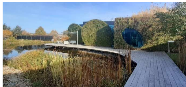
Obr. 15. Malá vodní nádrž pro sběr srážkové vody, LIKO-S ve Slavkově u Brna
