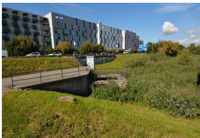
Obr. 18. Pohled na výpustné zařízení nádrže a bezpečnostní přeliv
