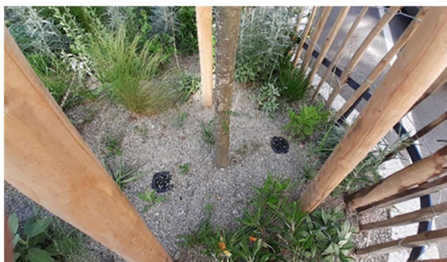
Obr. 17. Automatická podzemní bodová závlaha pro stromy
