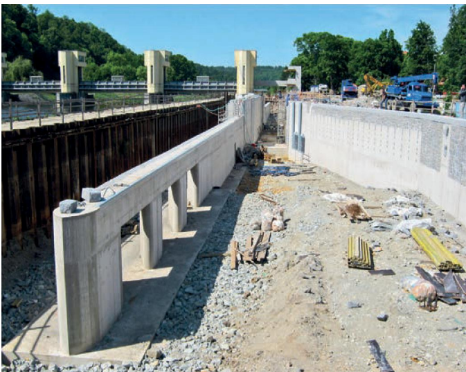
Obr. 3. Stavba plavební komory Hluboká nad Vltavou. Zdroj: Archiv autora
