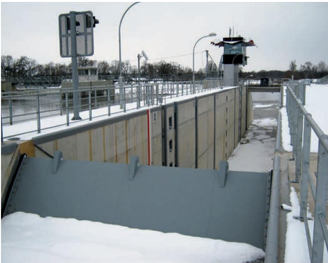
Obr. 2. Stavba plavební komory České Vrbné. Zdroj: Archiv autora
