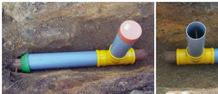
Obr. 4. Konstrukční provedení a realizace prefabrikovaných prvků PRO podle technického návrhu VÚMOP. Foto Z. Kulhavý
