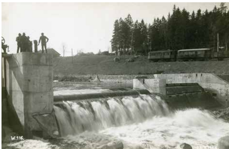
Obr. 6. Funkční zkouška nového jezu konstrukce Huber-Lutz. V pozadí projíždí elektrický vlak druhé nejstarší elektrické železnice v Čechách Rybník – Lipno nad Vltavou (rok 1929)
