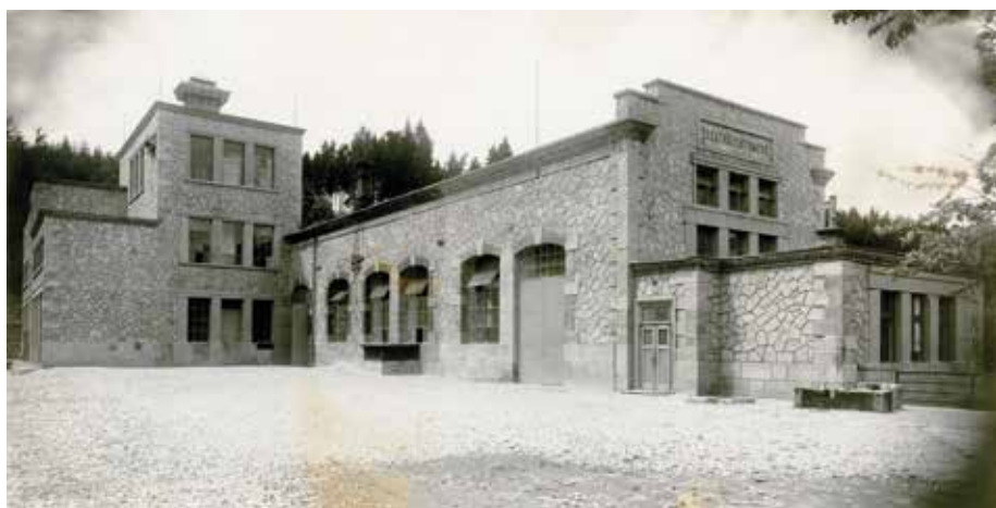
Obr. 7. Hala elektrárny po dostavbě a rozšíření. Nápadně světlé zdivo pravé části haly (římsky) je dostavěná část (po roce 1929)
