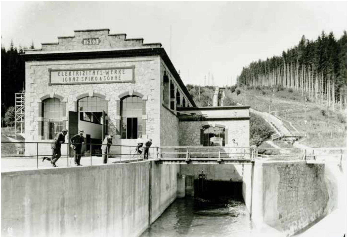
Obr. 3. Pohled na elektrárnu s komorou uzavíracích šoupat nad odpadním kanálem (kolem roku 1911)
