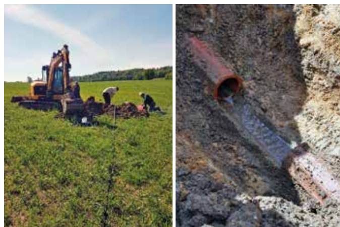
Obr. 1. Odkrytí sběrného drénu pro zjištění funkčnosti drenáže. Zdroj: Rakovnicko [online], foto P. Fučík
