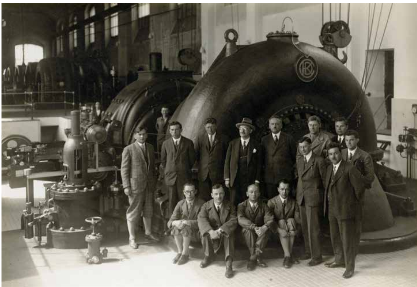
Obr. 8. Páté soustrojí ČKD s exkurzí konstruktérů a hydrotechniků. Uprostřed v brýlích a klobouku je autor hydraulického a konstrukčního řešení pátého soustrojí Ing. Jakub Karásek, konstruktér a vrchní ředitel ČKD (po roce 1929)
