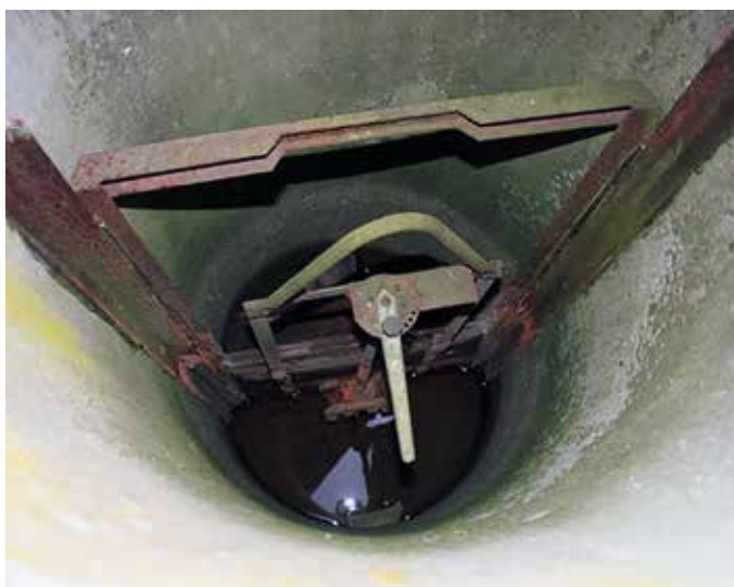
Obr. 7. Vyráběné a v praxi ověřené typy regulačních prvků. Vlevo: Příklad původního konstrukčního řešení hradítka na stavbě regulační drenáže Kolesa-Vápno v okr. Pardubice. Snímek z roku 2015, stavba byla budována v letech 1980–1981. Foto Z. Kullhavý. Vpravo: Příklad řešení průběžného plovákového regulačního prvku typu Water Gate fy. Agri Drain Corporation ( https://www.agridrain.com/shop/c84/water-gate/ )
