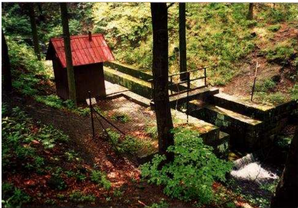
Foto 2 Měrný žlab a limnigrafická budka na povodí Malá Ráztoka
