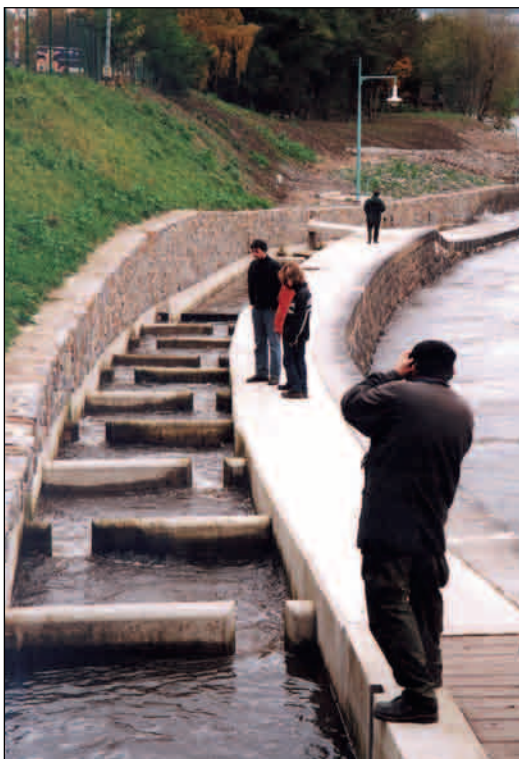
Štěrbínový rybí přechod. Vodní dílo Střekov na Labi.
