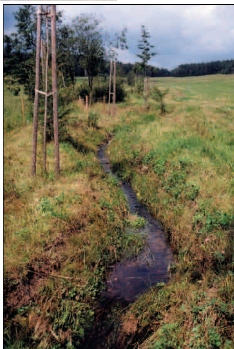
Revitalizace u Borové. Nové koryto potoka v horním úseku po dvou vegetačních sezónách. Koryto chrání před poškozením jednak malá kapacita a rozlivy větších průtoků do nivy, jednak dobře zapojený drn v březích.
