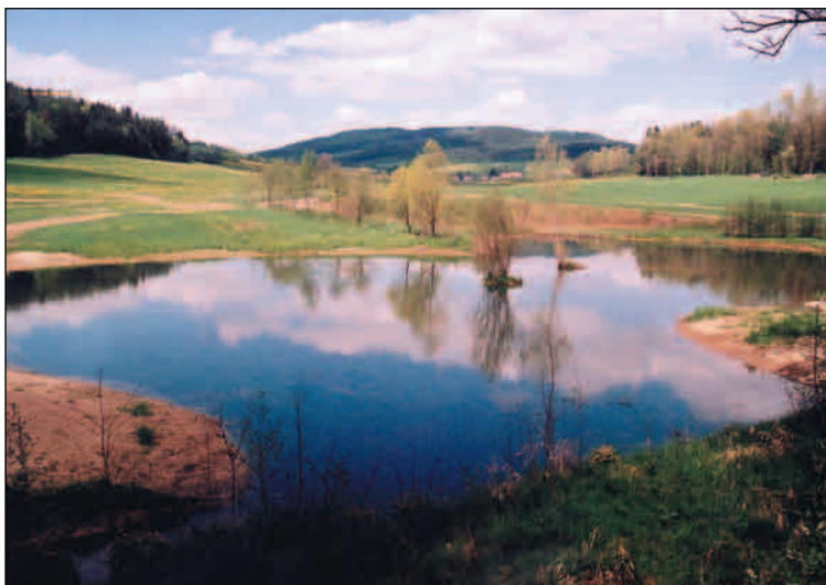
Borová na Českokrumlovsku. Revitalizovaný úsek potoka, dlouhý asi 3 kilometry, je zakončen větší tůň. Vznikla mimo jiné proto, aby zachycovala případné splaveniny, odnášené z revitalizovaného úseku, a tak předešla stížnostem dalších uživatelů potoka. Tůň má mírně sklonité svahy, není vypustitelná a hradí ji prostý přeliv z kamenné rovinaniny. Stav po dokončení výstavby v roce 2001.
