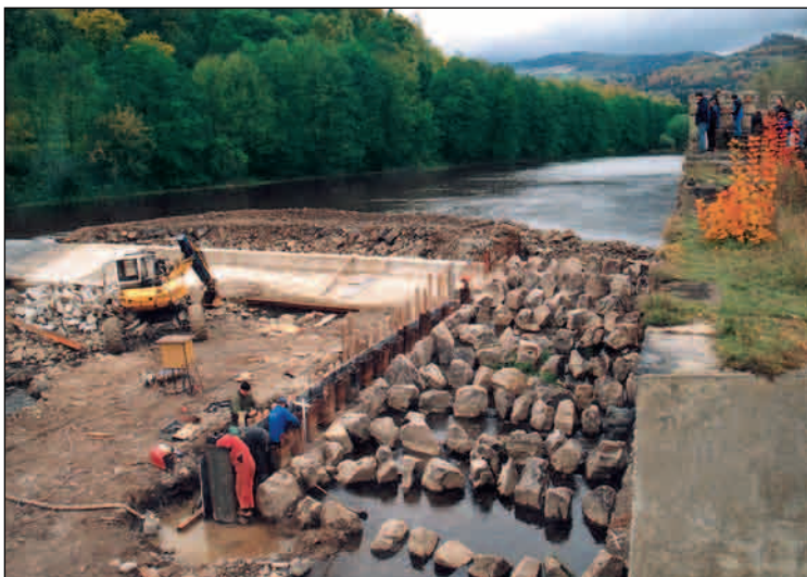
Výstavba komůrkového rybího přechodu po straně jezu v Perštejně na Ohři, podzim 2002. Komůrky oddělují řady kamenů, zasazených do dna.
