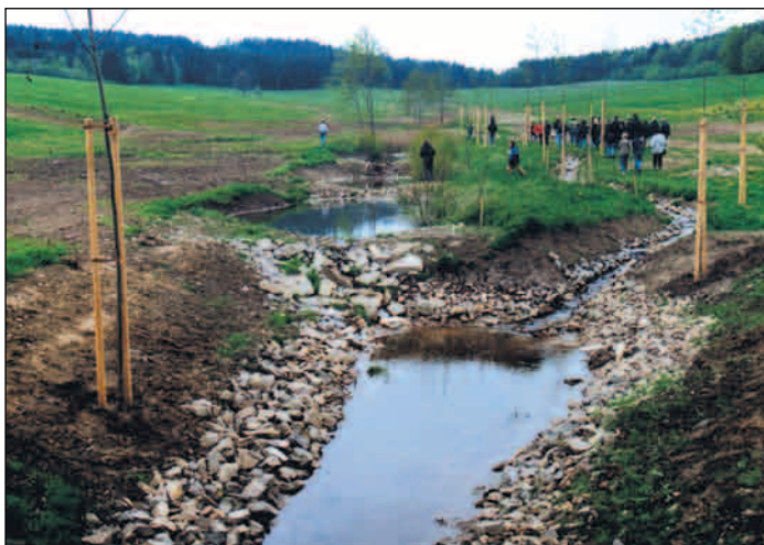
Revitalizace potoka a nivy u Borové na Českokrumlovsku. Napřímené upravené koryto, opevněné tvárnicemi, bylo zčásti zasypano, zčásti proměněno v soustavu tůní. Stranou bylo vytvořeno nové koryto, přírodě blízkého tvaru, s výrazně menší kapacitou. Stav po dokončení prací v horním úseku revitalizace, v roce 1999.
