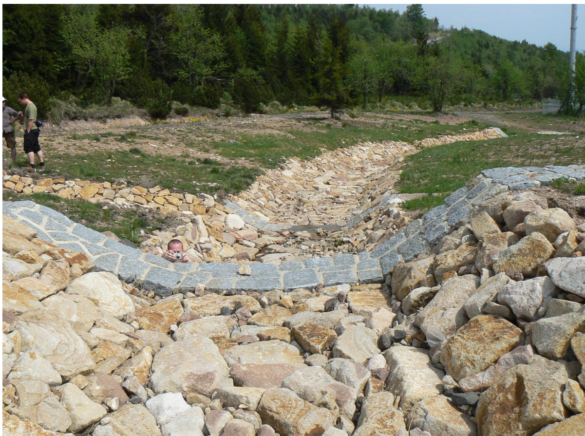
Obr.8.3.2 Kamenný práh ve dně. Bystřice. Foto F.Křovák; 2010
