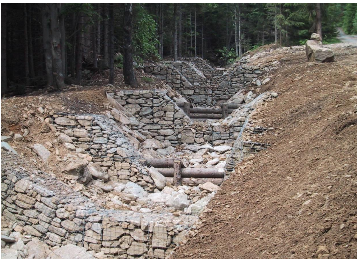
Obr. 8.11.2 Soustava objektů hrazení. Černý potok. Foto F.Křovák; 2010
