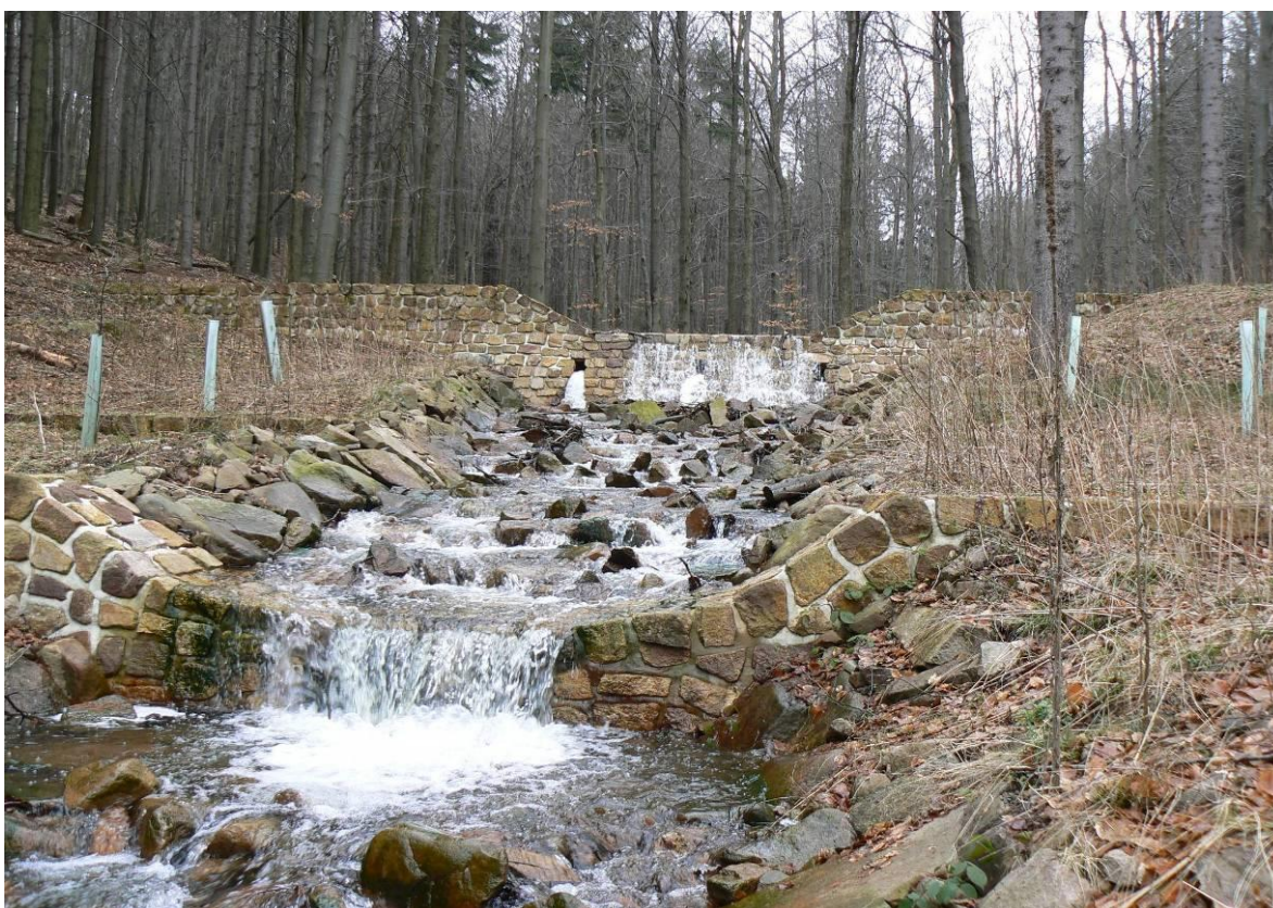
Obr. 8.10.6 Kamenná přehrážka se stupni. Nerudův potok. Foto F.Křovák; 2010
