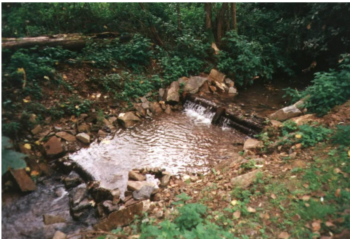
Obr. 8.9.2 Kamenitý jízek. Oplanský potok. Foto F.Křovák; 2006
