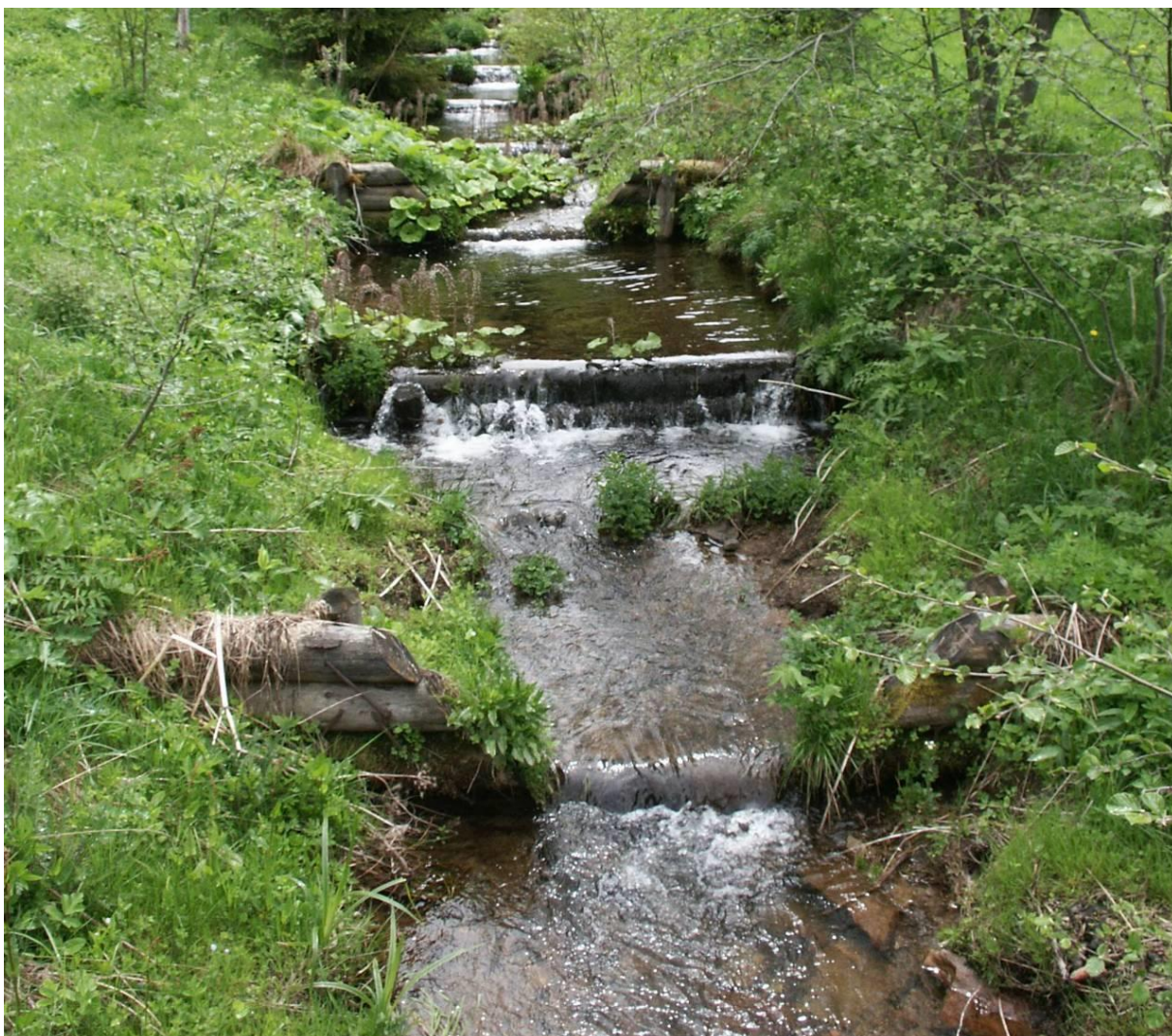
Obr. 8.5.3 Dřevěný stupeň. Orlické záhoří. Foto F.Křovák; 2010
