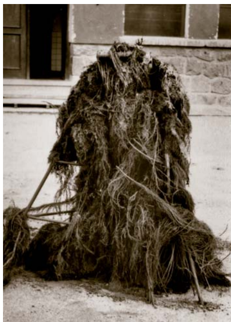
Substrát umístěný na konstrukci
