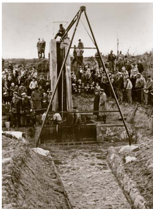
Výlov rybníka pod hrází r. 1959 SR Nižbor
