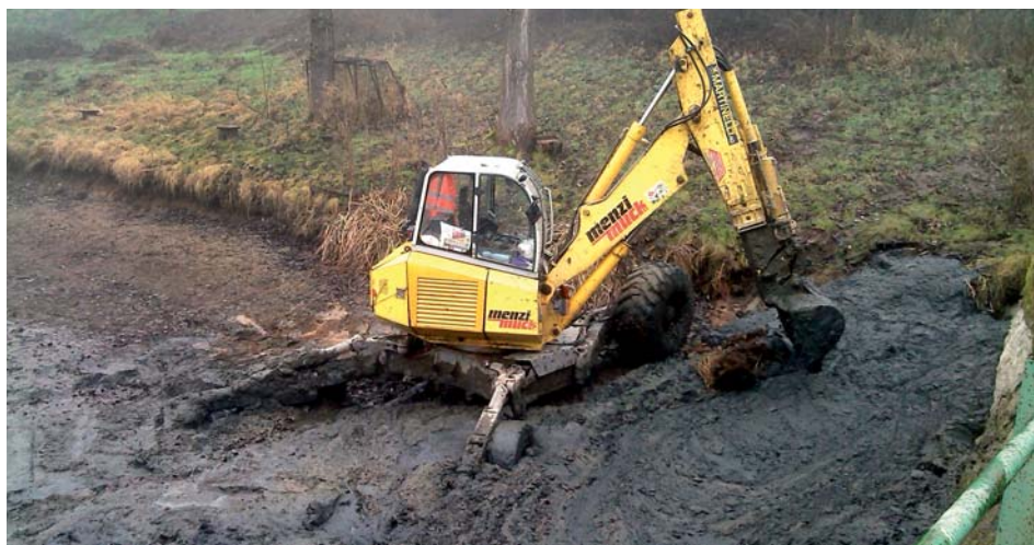
Odbahňování rybníka s použitím mechanizace
