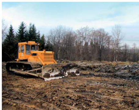
Buldozer při rekultivaci okraje rybníka
