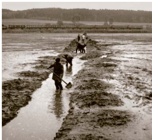
Obnova zabahněných stok
