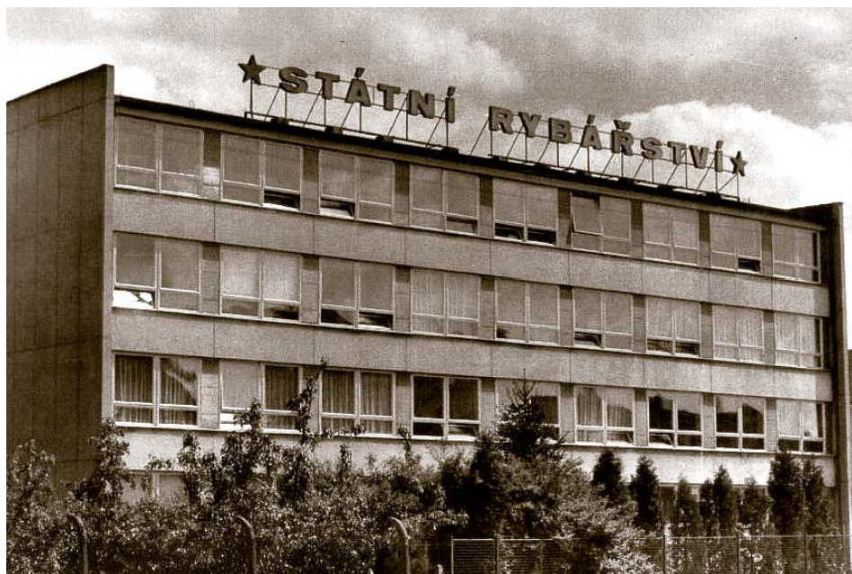
Budova Státního rybníká po uvedení do provozu (1964)
