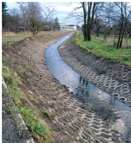
Vyčištěné a opravené odtokové stoky velkého rybníka
