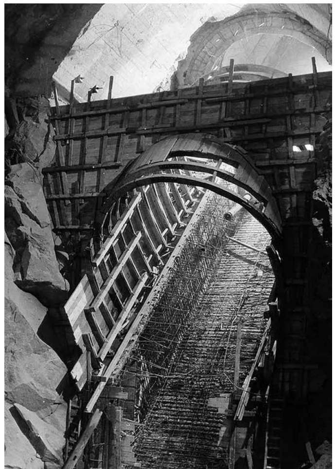
Obr. 5. Šikmý tunel do budoucího prostoru elektrárny
