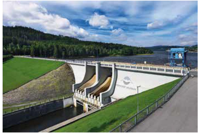
Obr. 7. Hráz vodní nádrže Lipno I
