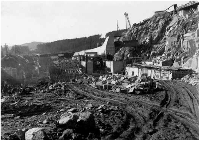
Obr. 3. Betonování gravitačního bloku
