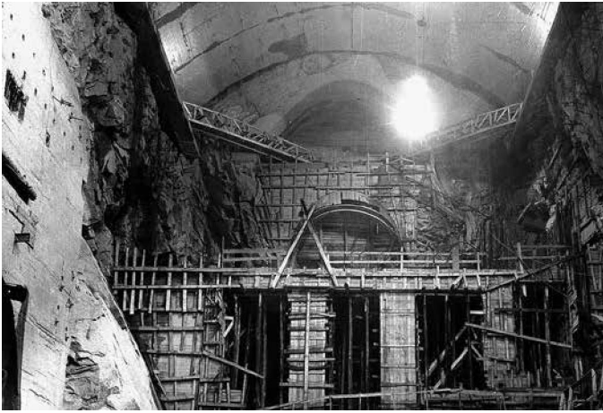
Obr. 6. Výlom jádra v podzemní hydrocentrále
