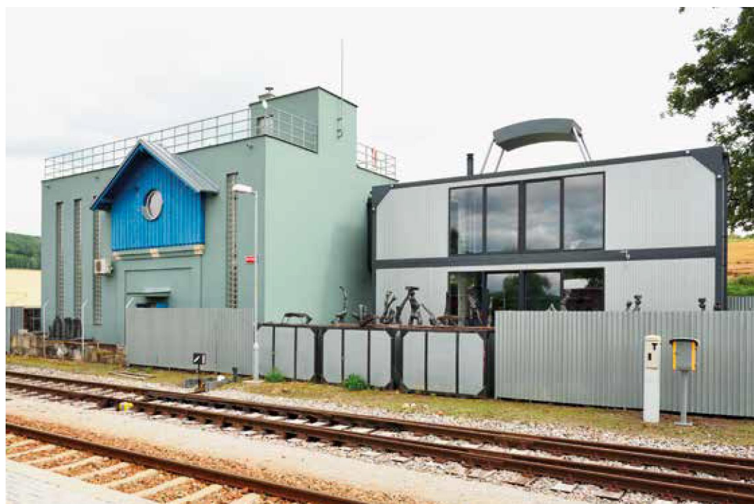
Obr. 7. Přestavba vodojemu v Kájově na ateliér
