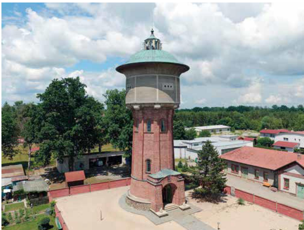
Obr. 1. Věžový vodojem v Třeboni
