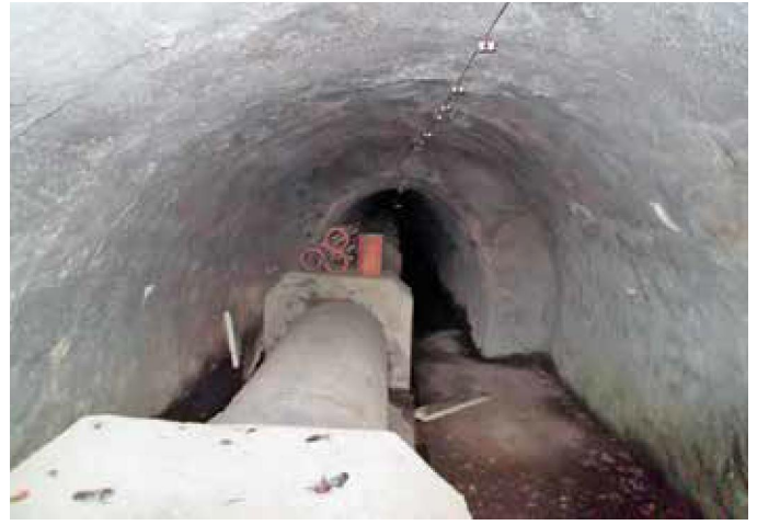
Obchvatný kanál – štola II – úsek u horního vstupu
